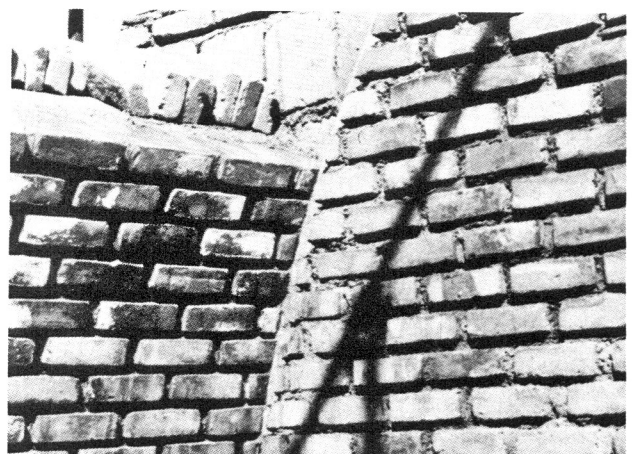
این بخش ازطاق درضخامت سه آجر اجراشده است
